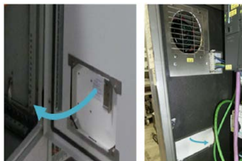
Circuit intérieur Sortir d'air froid
