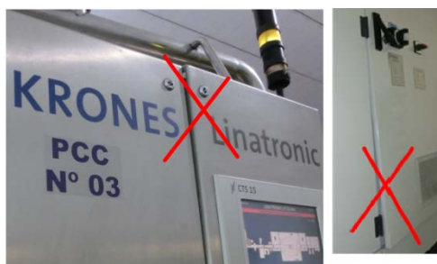
Portes d'armoire électrique endommagées
