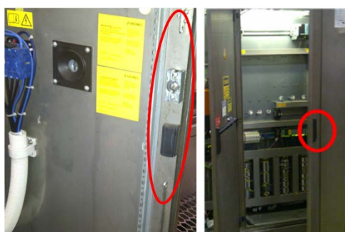
Verrouillages de porte endommagés
