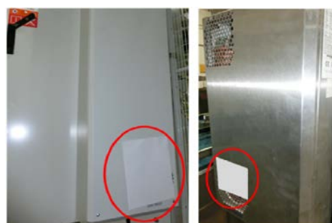
Ventilateur extérieur - Ouverture d'aspiration en bas
