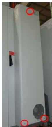
Appareil de refroidissement - fixation couvercle
