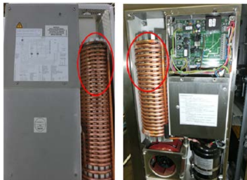
Serpentins du circuit extérieur
