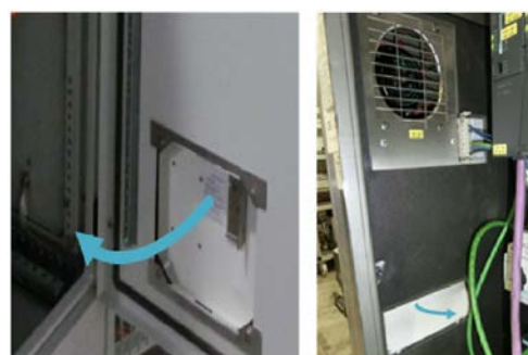
Ventilateur intérieur - Ouvertures de sortie en bas
