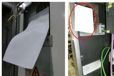
Ventilateur intérieur - Ouverture d'aspiration en haut
